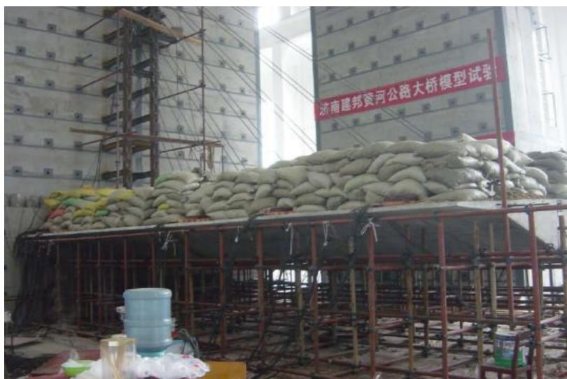
图 5-9 结构技术中心负责济南建邦黄河公路大桥模型试验研究
